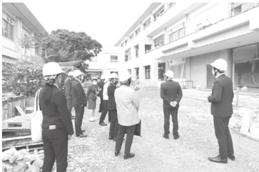
長寿命化工事中の国東小学校教室棟
