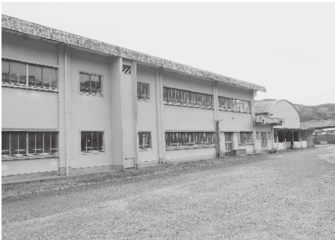
令和5年度解体予定の 旧上国崎小学校校舎・体育館
