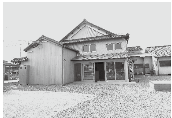
古民家を改修したテレワーク施設
